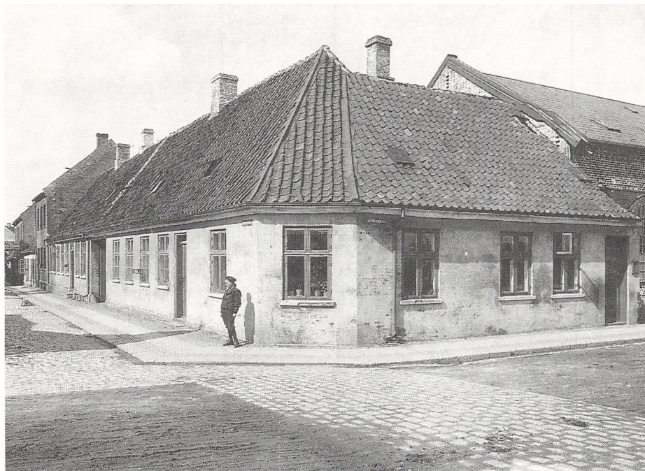
Fig. 8. Hjørnet af Hersegade og Jernbanegade. Maskinfabrikens hal skimtes til højre, 1893-1907. (Roskilde lokalhistoriske arkiv).
