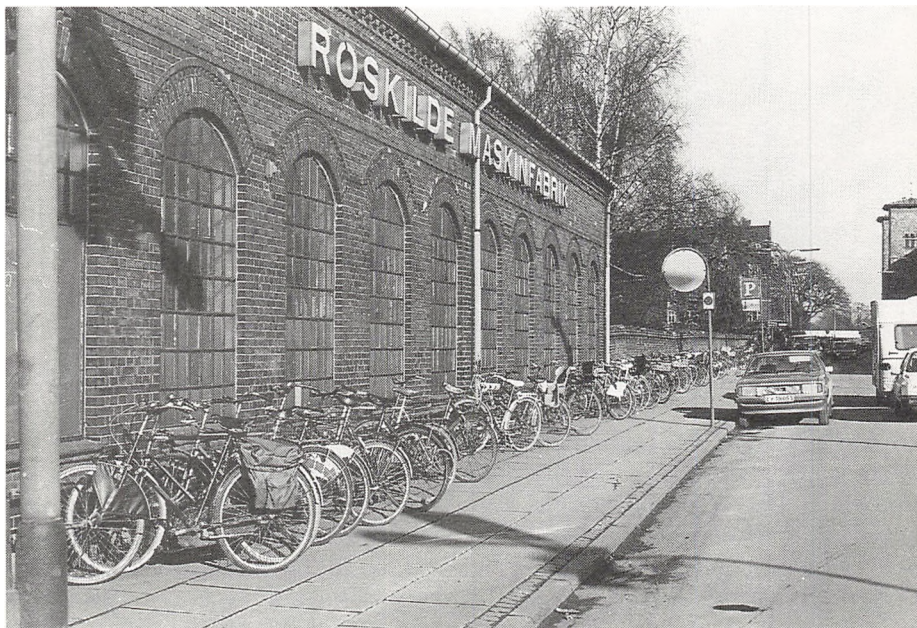
Fig. 1. Maskinhallen til Roskilde Maskinfabrik med Roskilde Banegård i baggrunden til højre. (Foto Bent Oslev 1987).
