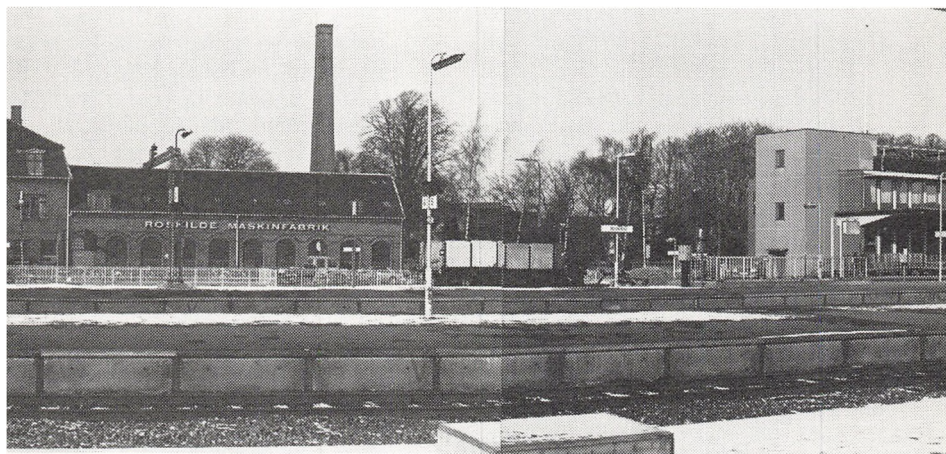
af de to tårne og Margrethespiret. På hjørnet af Hersegade og Jernbanegade ligger til højre Roskilde Maskinfabrik med hjørnebygning, maskinhal og skorsten. Til højre for Maskinfabrikken ligger Græbrødre Kirsegård, og til slut i billedet anes posthuset ved stationsbygningen. (Foto Bent Oslev 1987).
